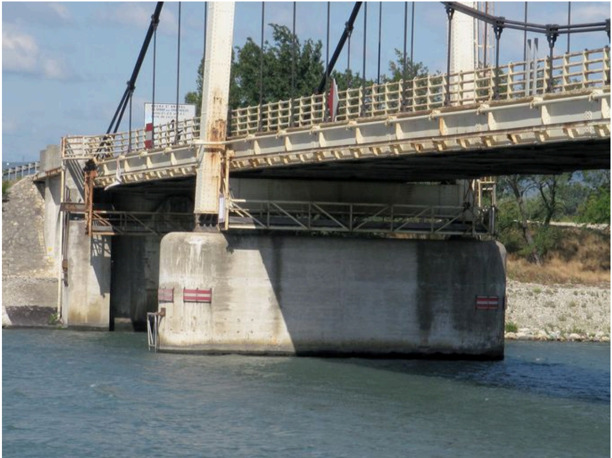
Pile supportant le pylône de la rive droite, face aval
