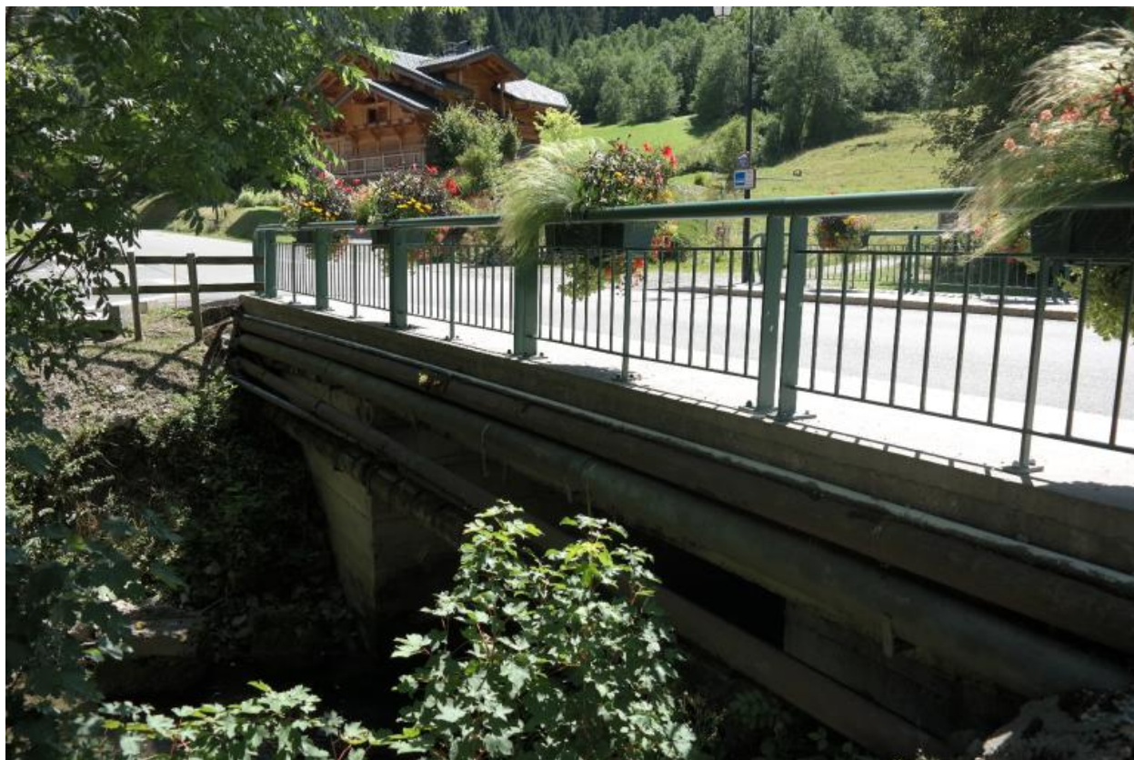
Pont de Villapeyron vue de la face aval
