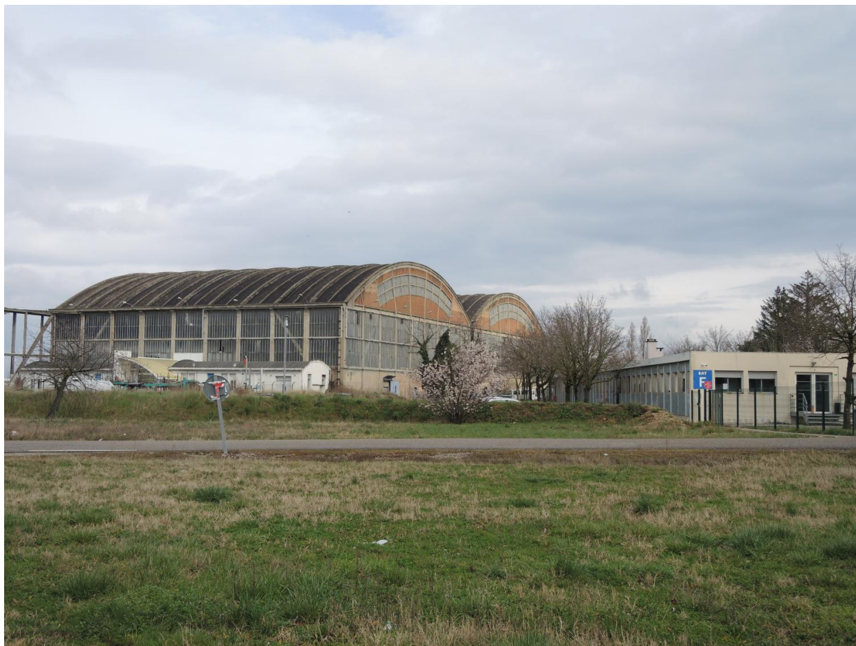
Hangar VI photo vue d'ensemble
