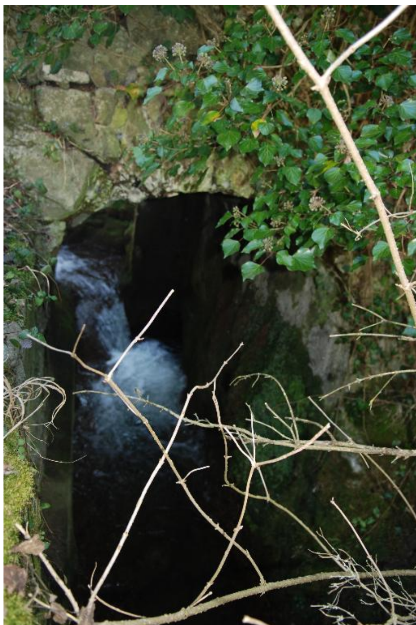
Ruisseau passant sous le pont routier de la route d'Héry
