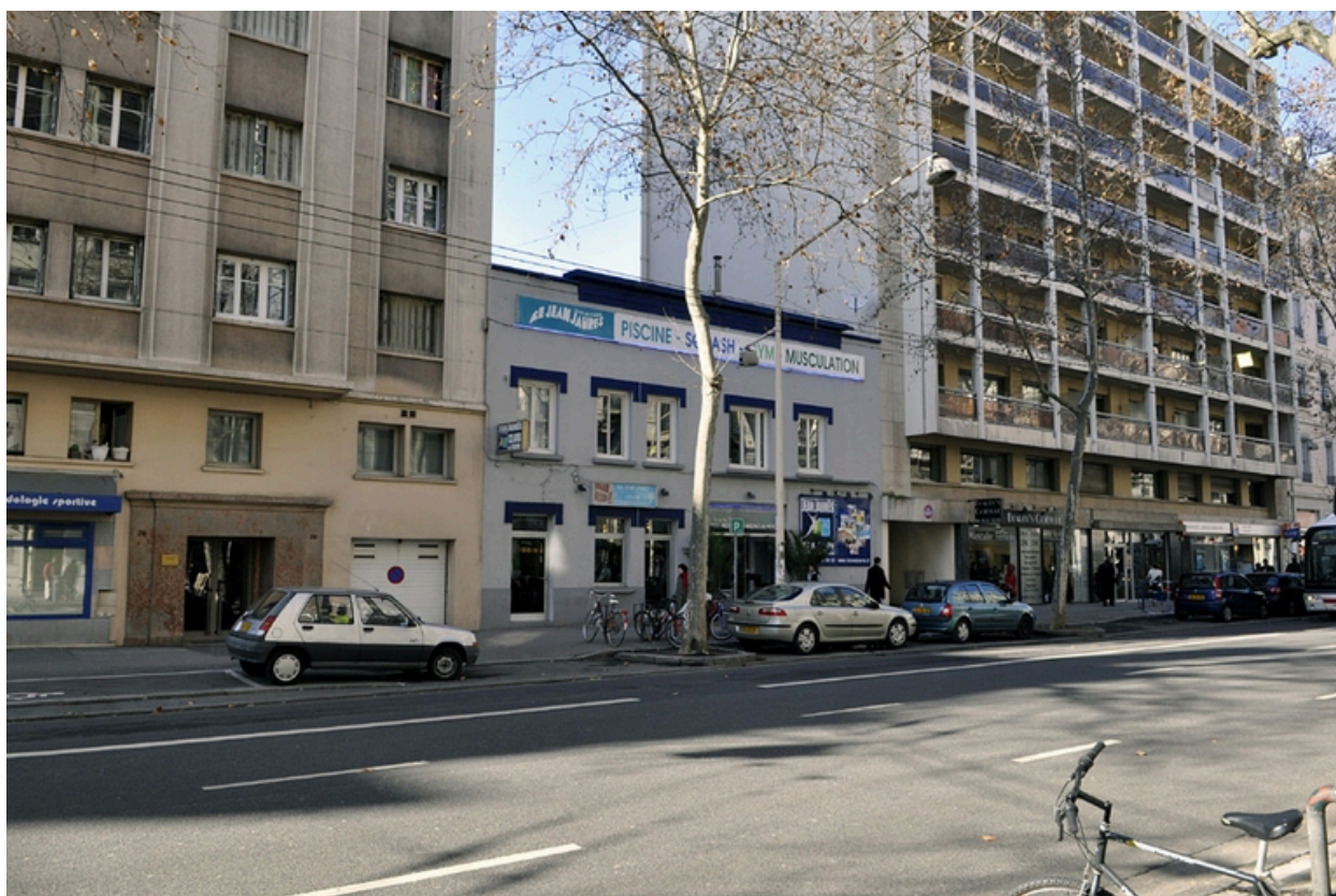
Vue d'ensemble sud-est
