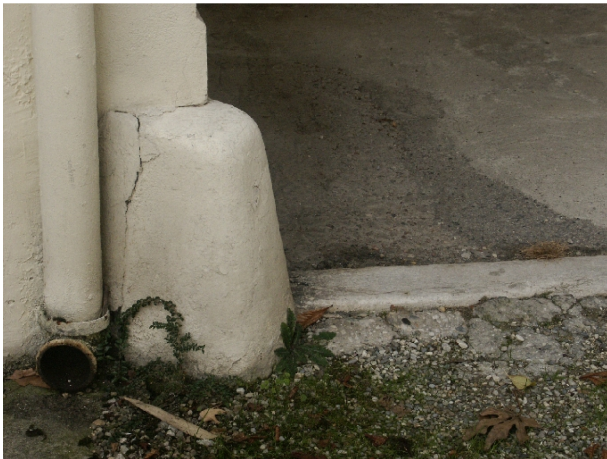
Chasse-roue à l'entrée du corps de porche
