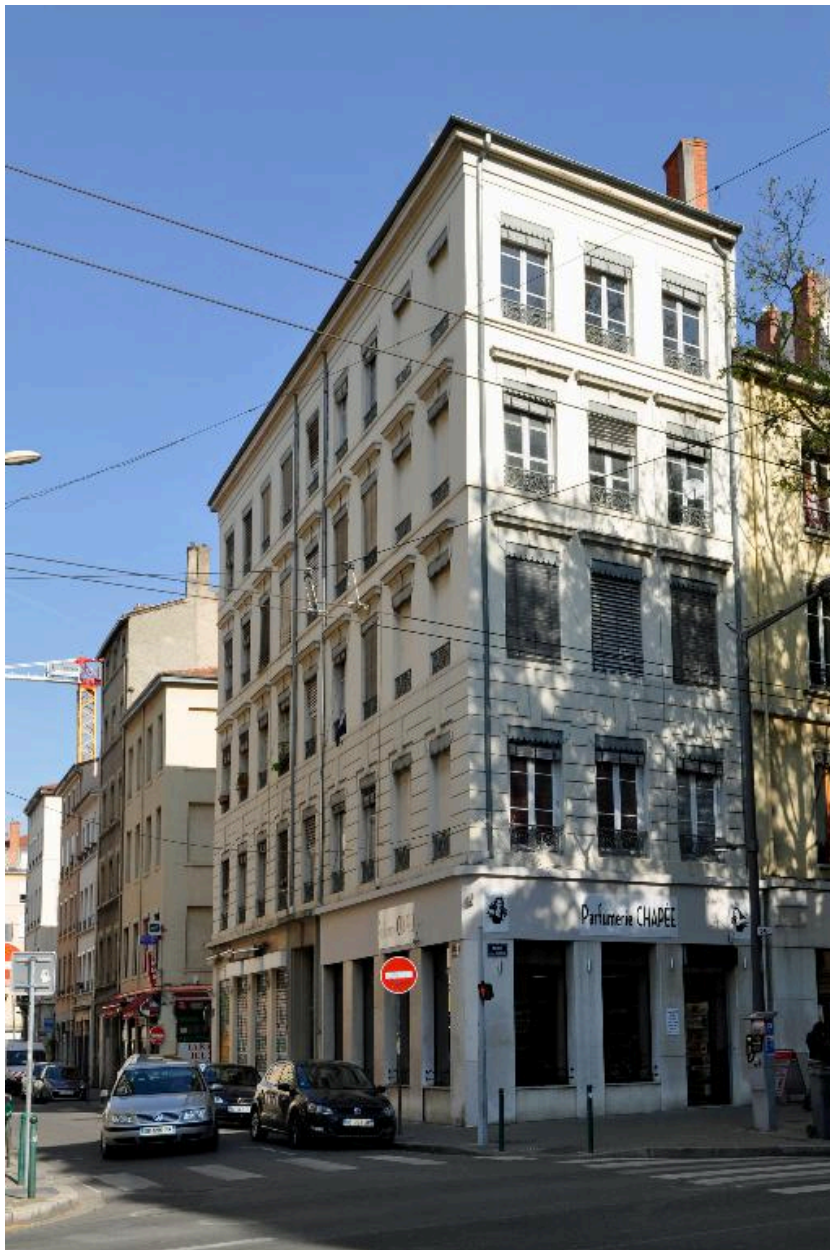
Vue d'ensemble, depuis le sud-est (avenue Jean-Jaurès)
