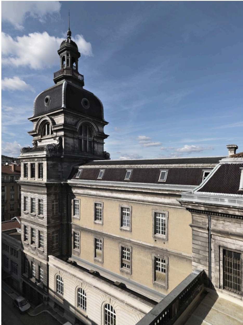
Bâtiment C. Façade sud et dôme Pascalon depuis le sud-est
