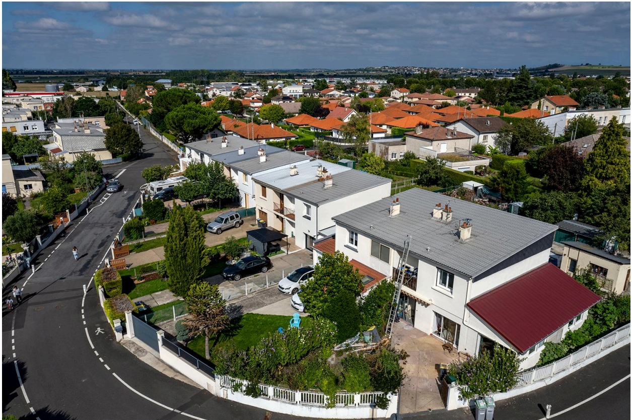
Détail de l'extension nord-ouest de la cité, construite en mode "Castor".
