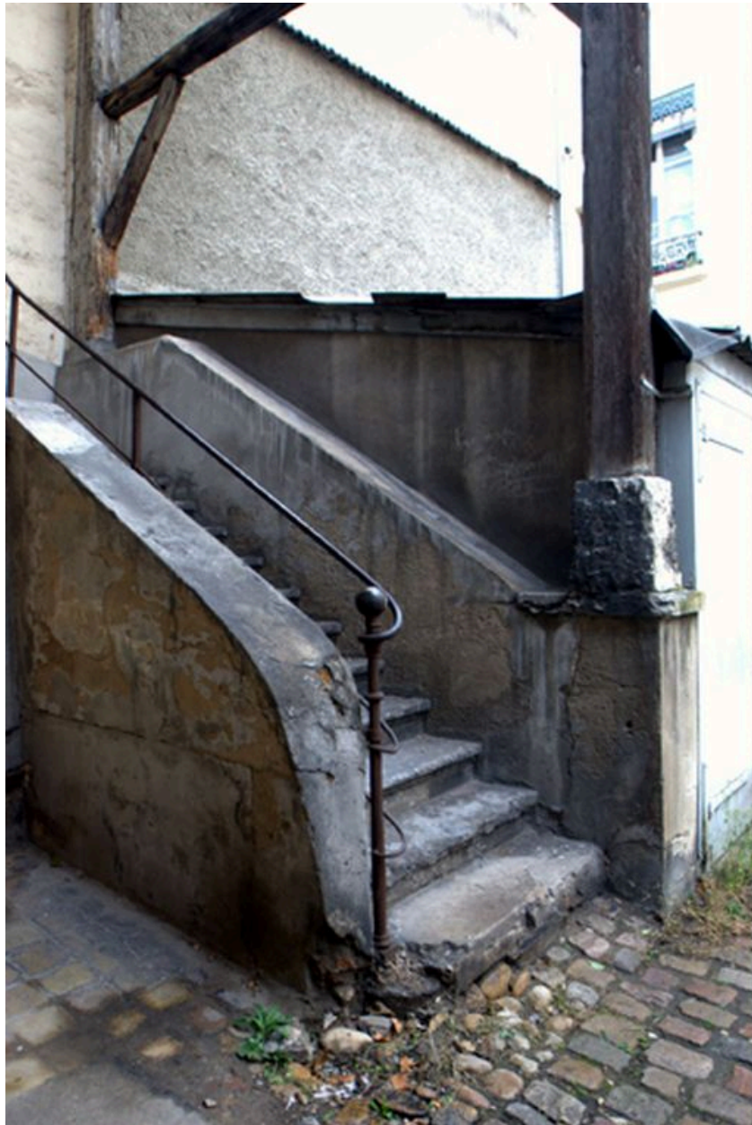
Le départ de l'escalier depuis le sud
