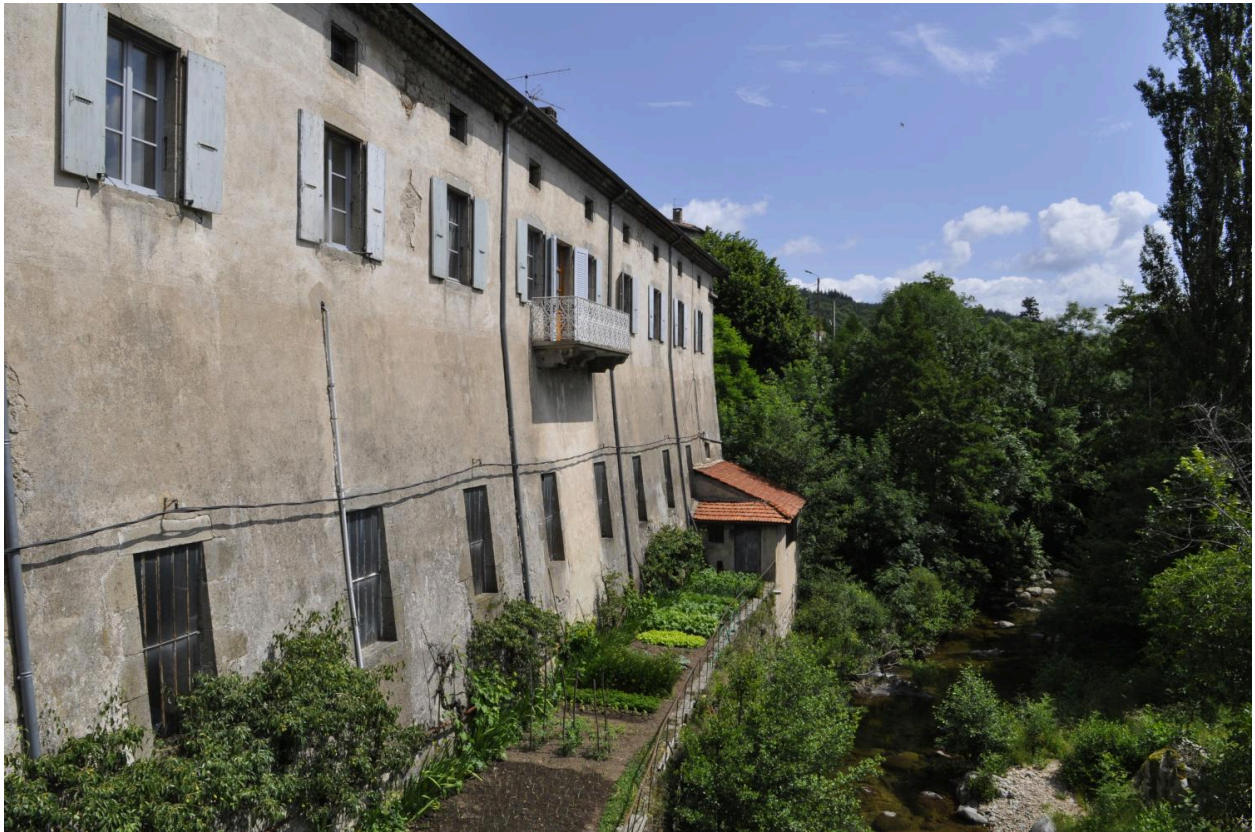
Vue d'ensemble façade ouest et jardins ouvriers
