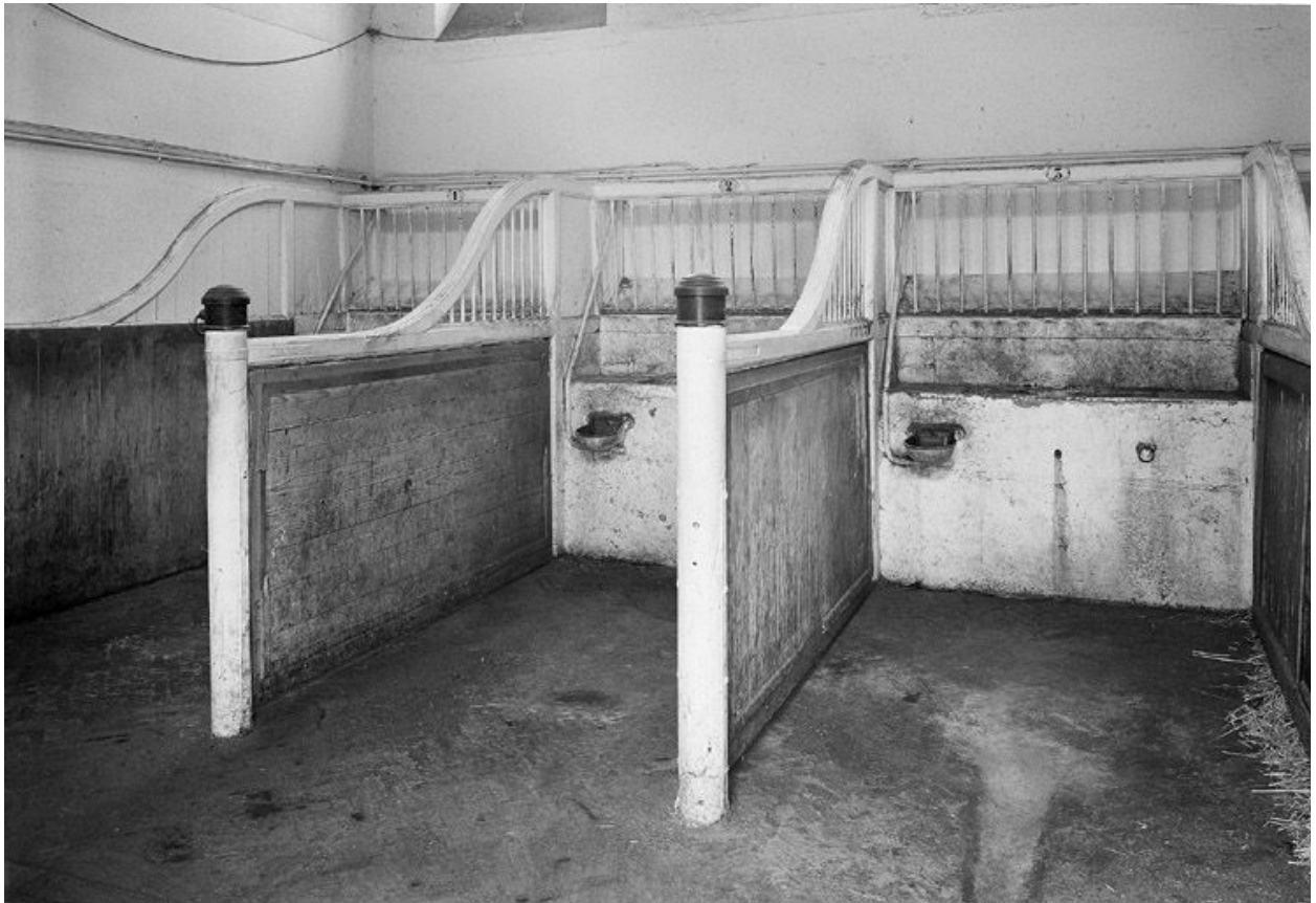
Grandes écuries, détail des stalles
