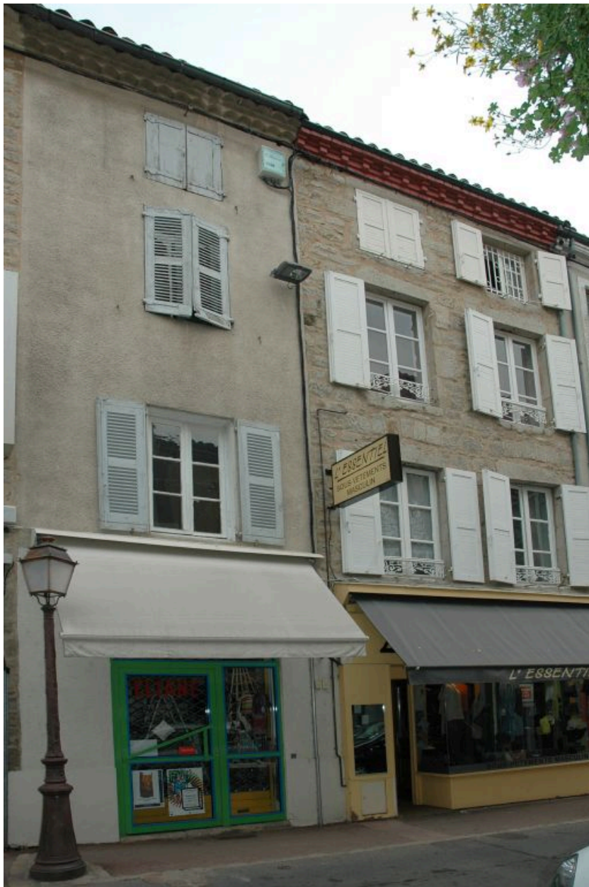
Vue de situation (maison de droite).
