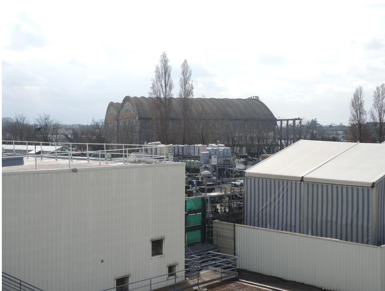
Hangar VI photo vue d'extérieur (photo prise du toit de Castorama)
