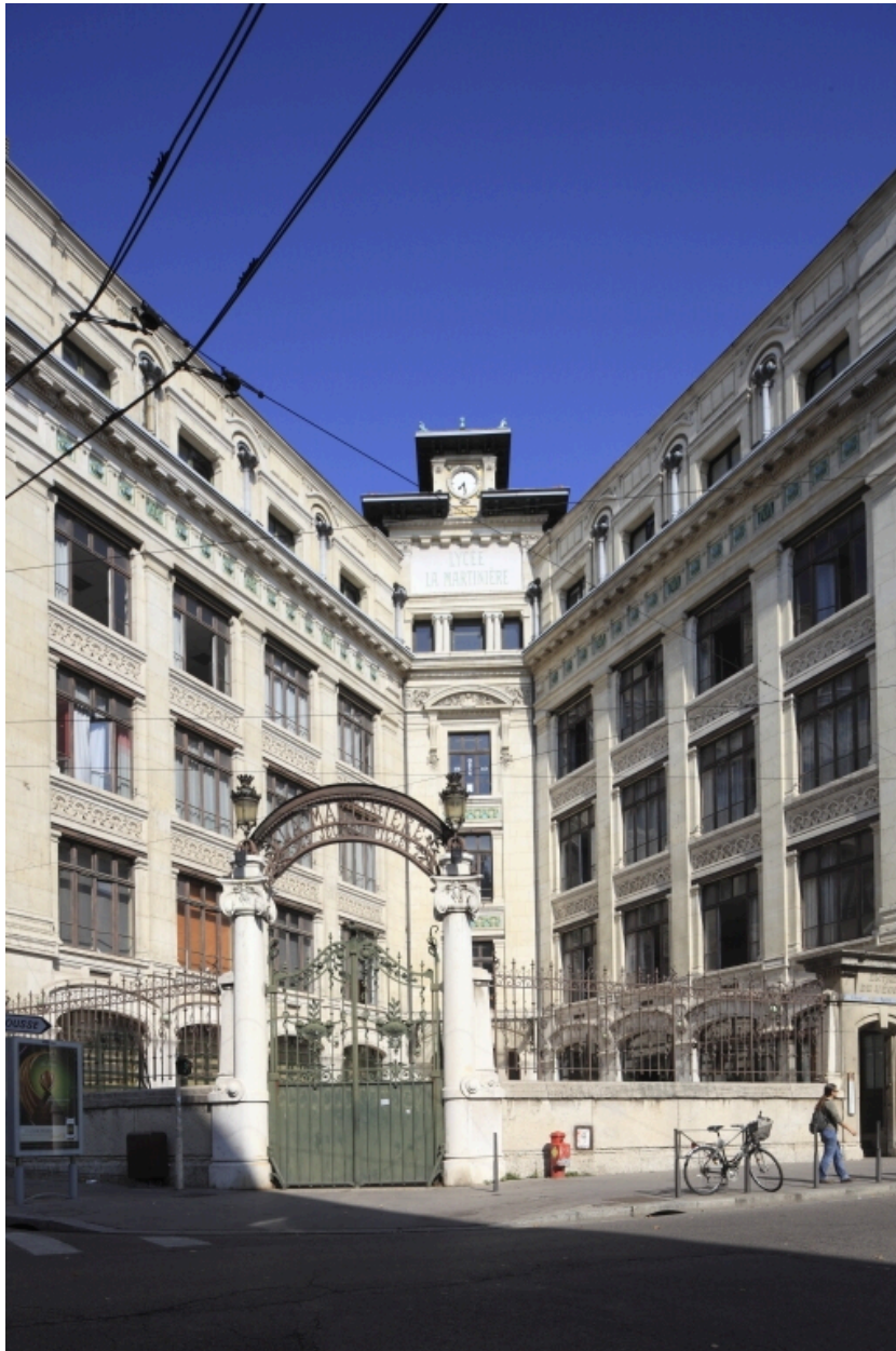
Vue générale des façades sur la place Tobie Robatel.
