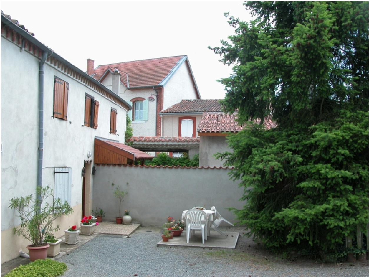
Le Bourg, maison (1988 C 156, 157, 201, 202 partie), non repérée. Vue arrière.
