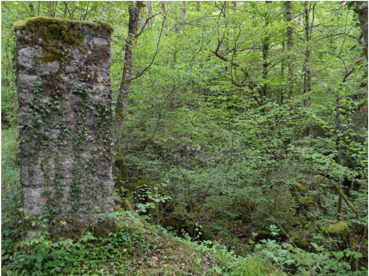
Ruines de l'ancien moulin Bovagnet
