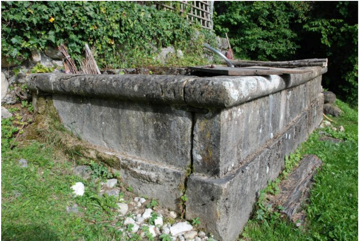
2015 C6 435, bassin. Détail angle droit avec agraphe.
