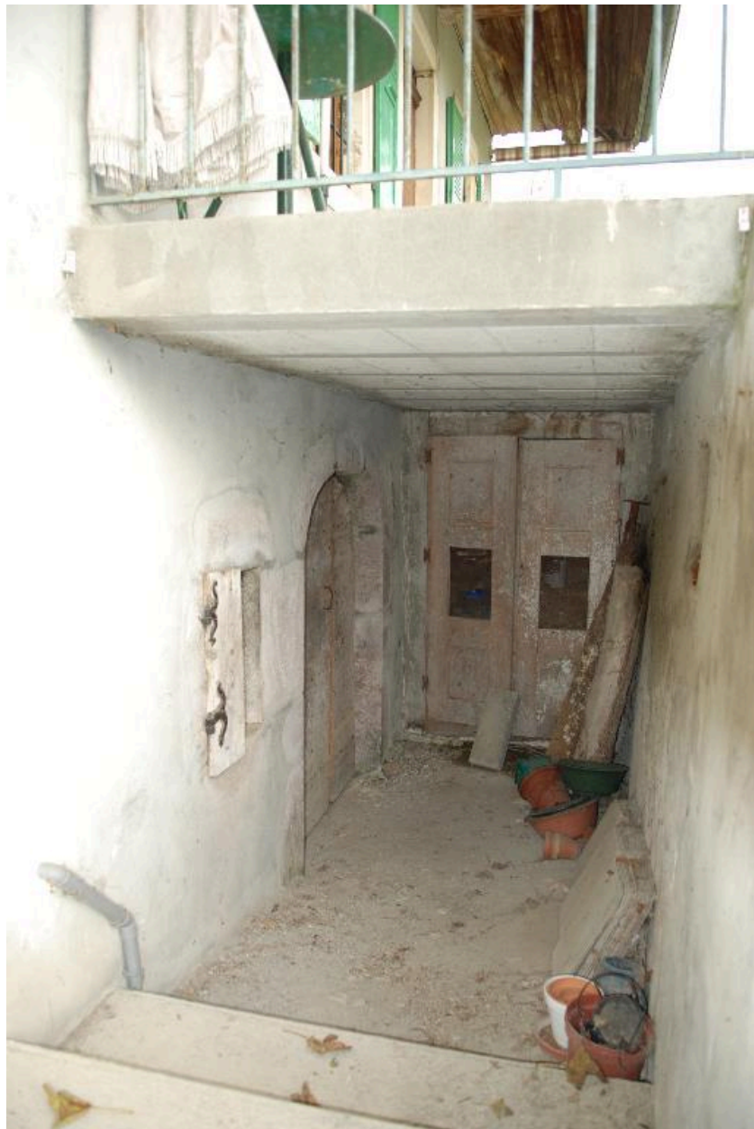
Vue d'ensemble de l'accès à la cave.
