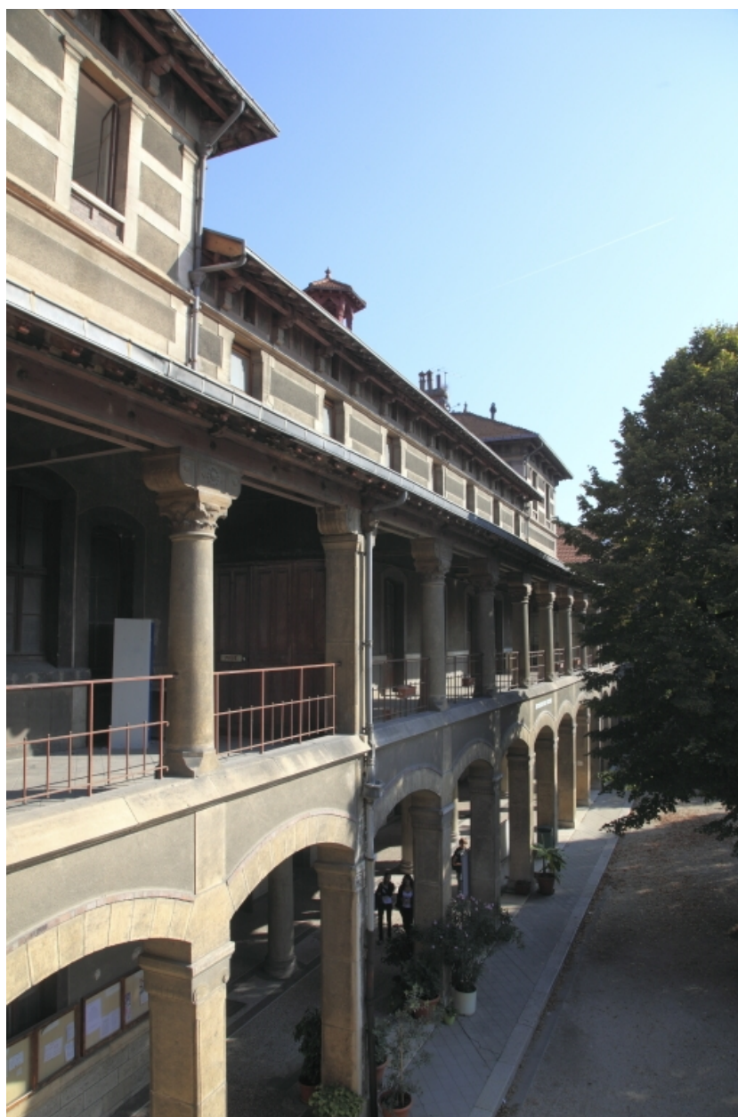
Cour H. Superposition des galeries, desservant les espaces du lycée au rez-de-chaussée, les appartements à l'étage.
