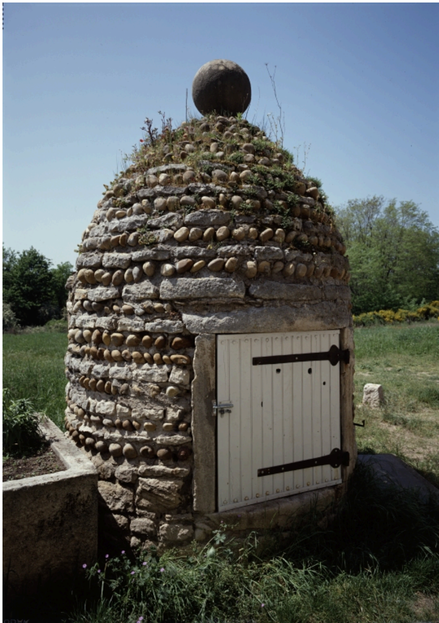
Ferme de type C, située sur la commune de Saint-Didier-de-Formans, au lieu dit Roncheveux, parcelle B1 469 Puits couvert en dôme, dans la cour.
