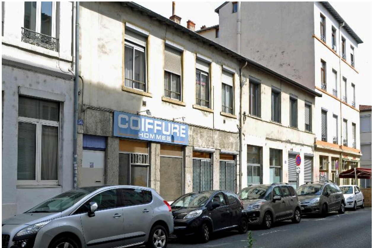
Vue générale, élévation sur rue
