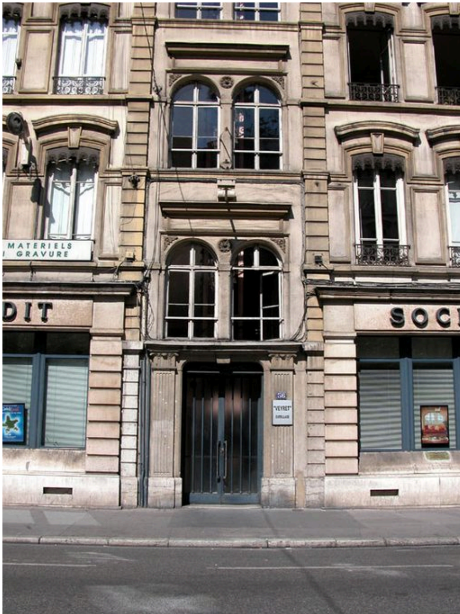
Partie inférieure de la travée d'escalier
