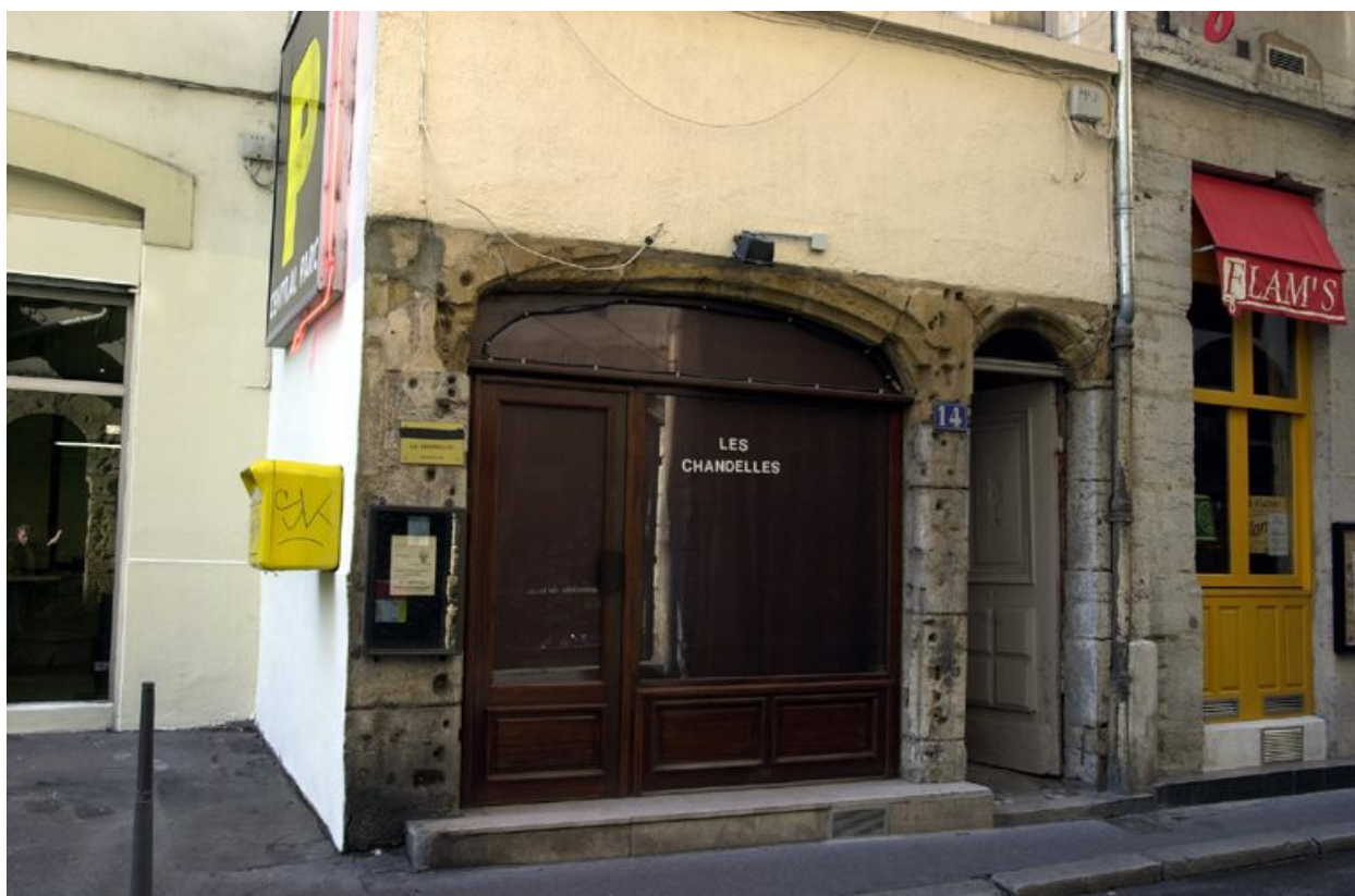
Elévation antérieure : le rez-de-chaussée
