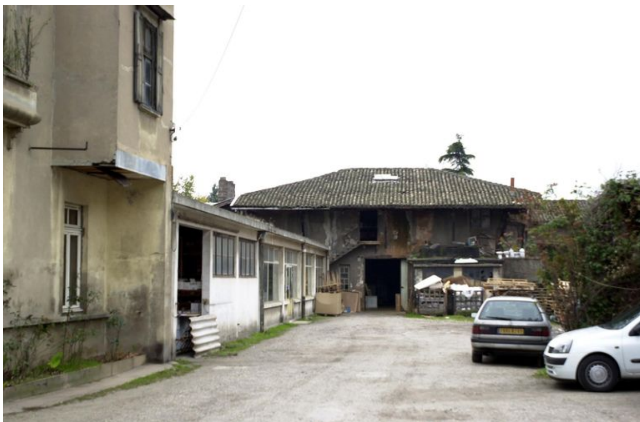
Entrepôt et ferme, façades sur cour
