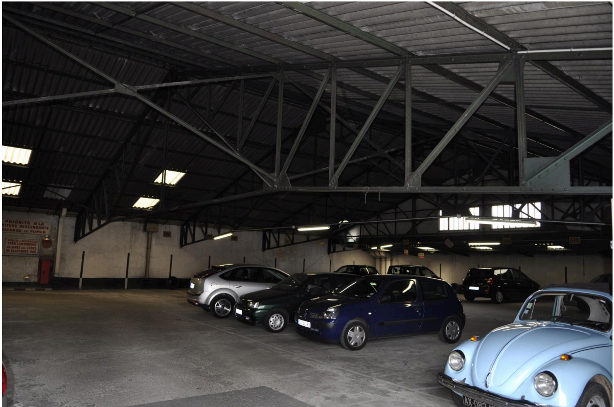
Vue intérieure du parking souterrain à charpente métallique
