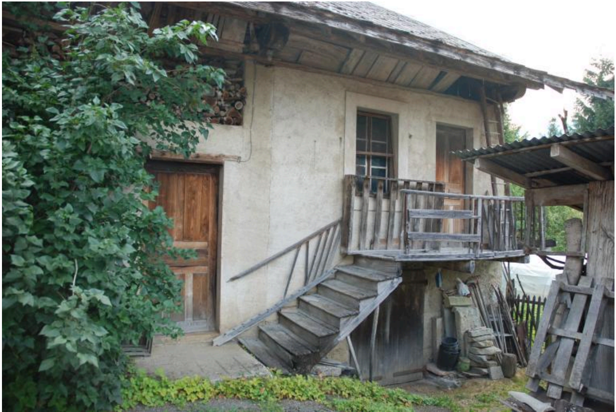
Vue du bâtiment annexe.
