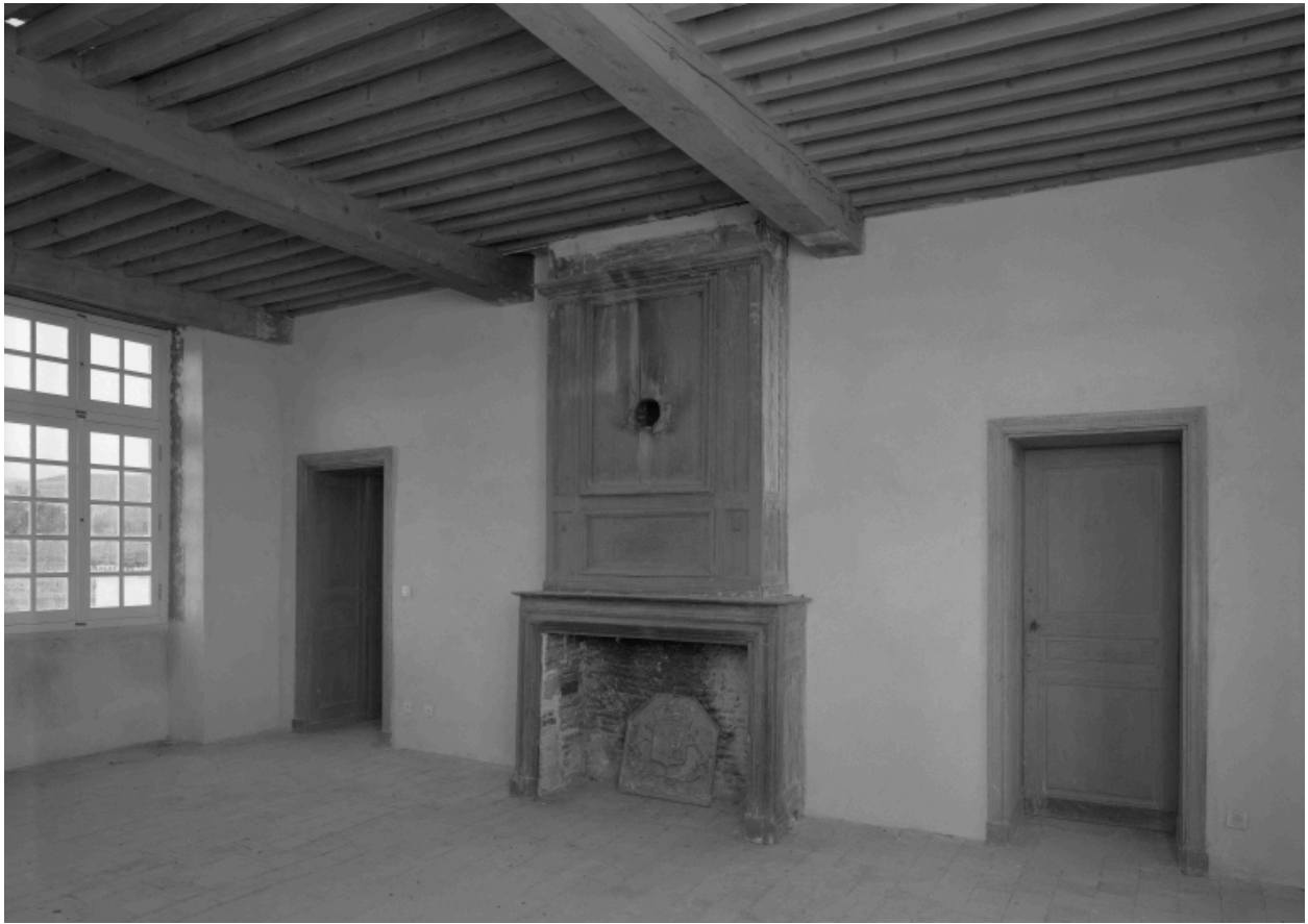
Aile ouest, premier étage, vue intérieure de la salle.
