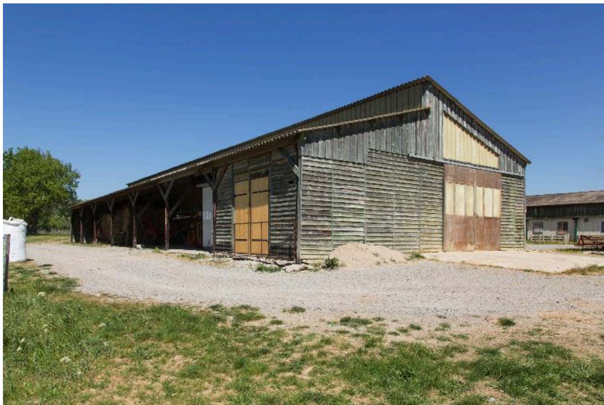
Ferme caprine : hangar de stockage
