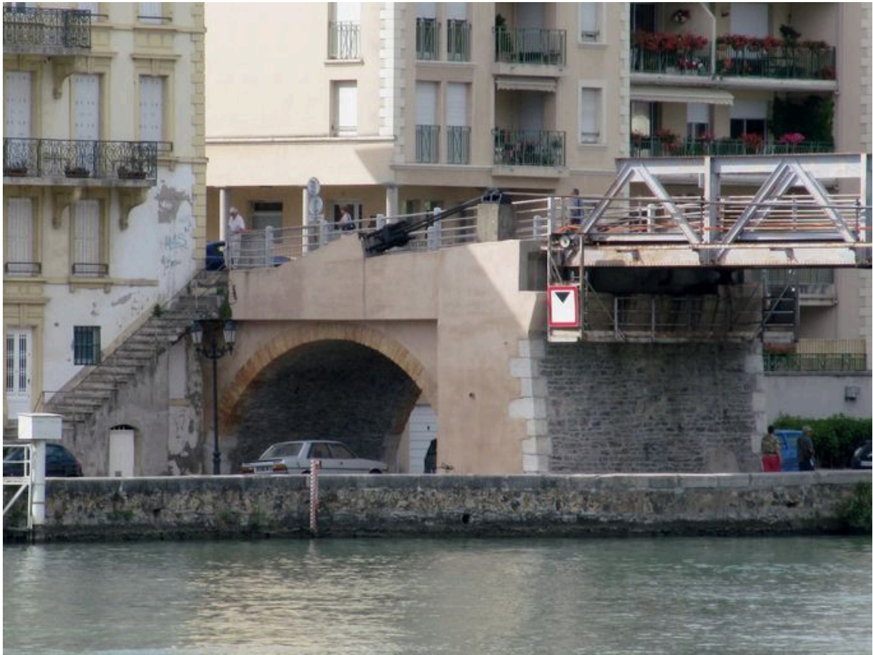
Vue partielle, culée droite, face aval (depuis la rive gauche)
