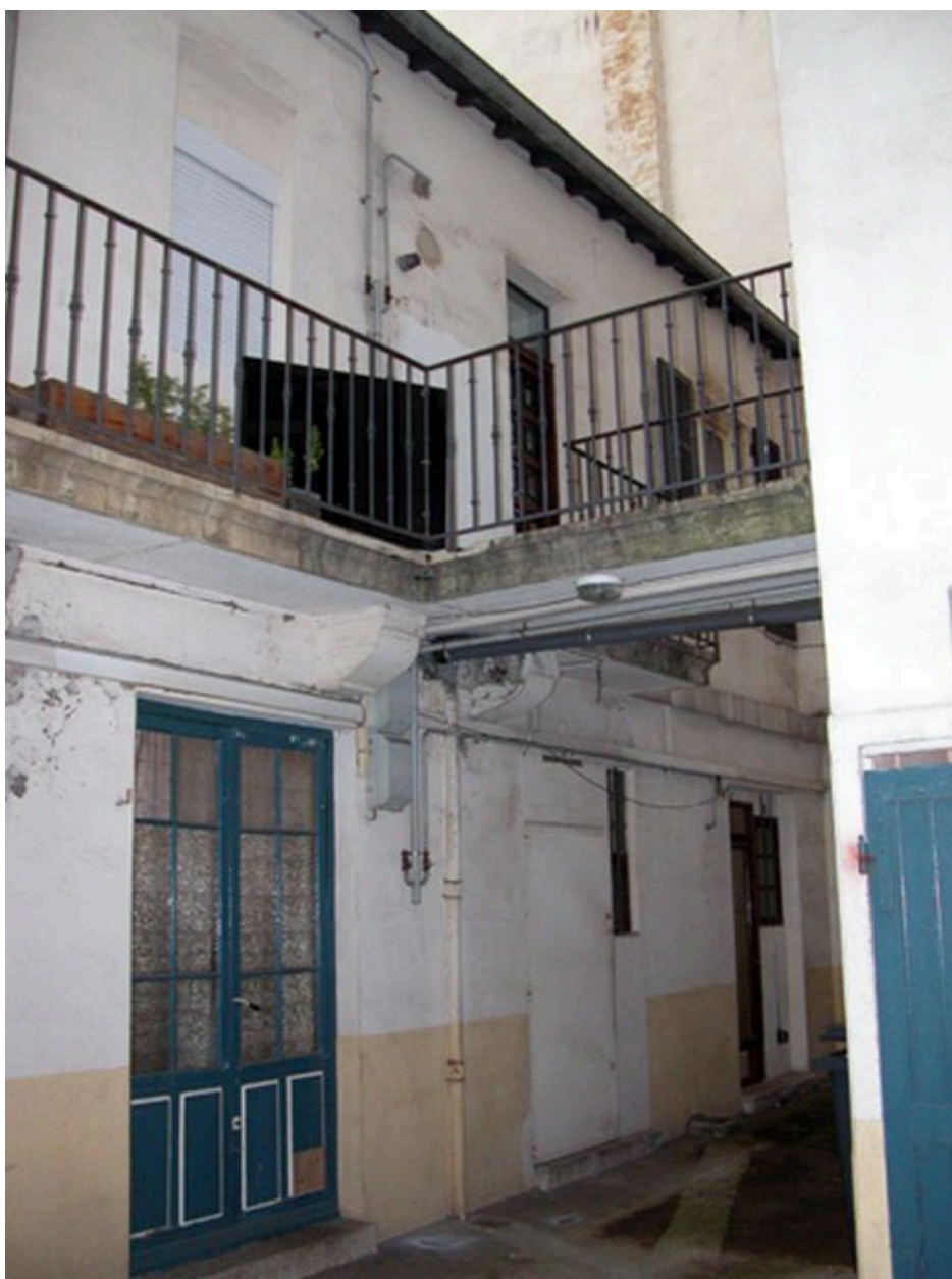
Partie centrale de l'élévation
