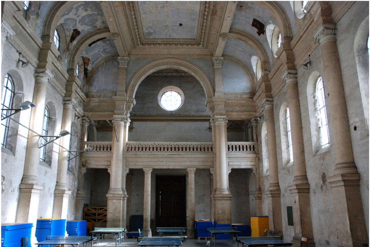
Nef, détail des premières travées
