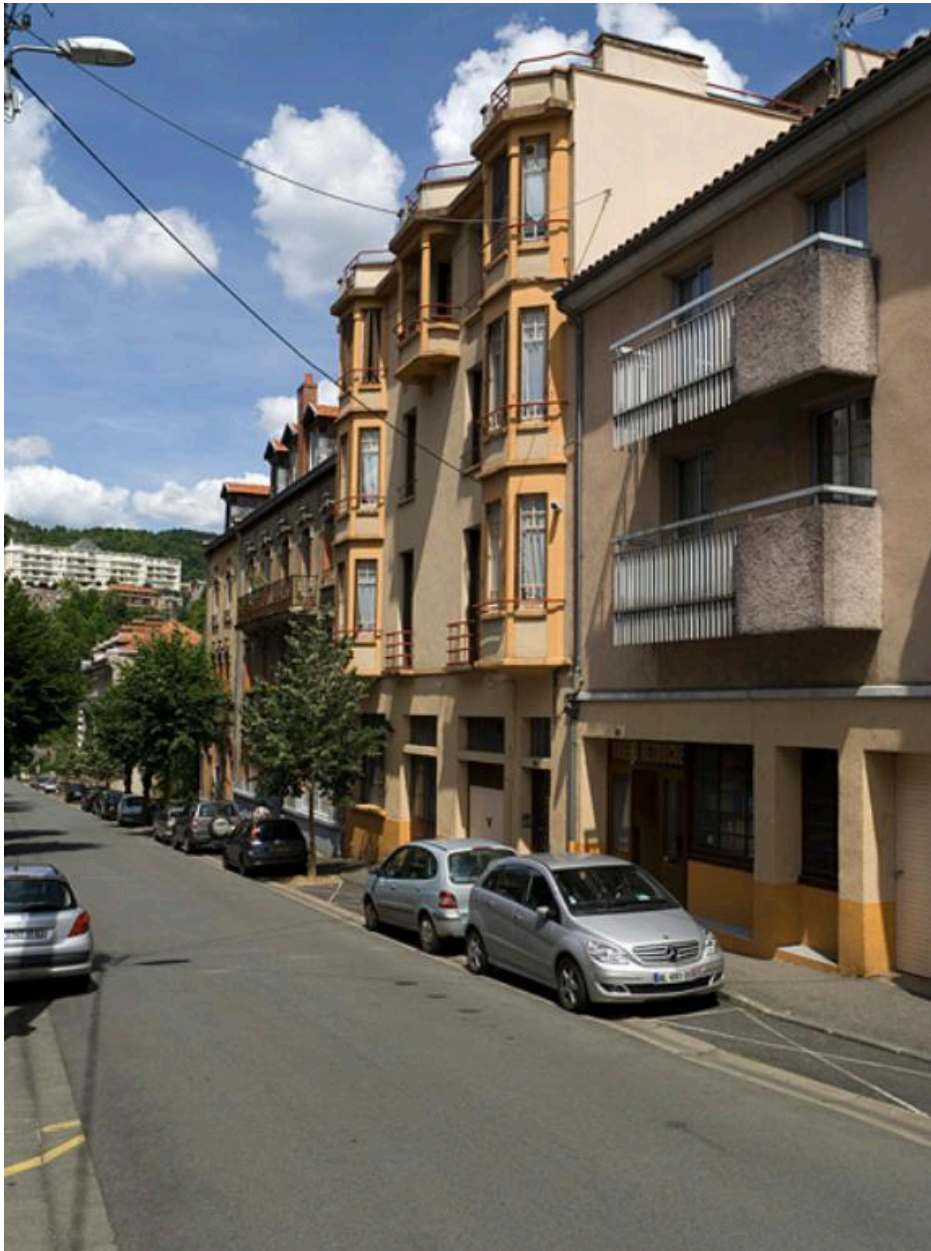
Exemple de bâti perpendiculaire à la pente, avenue Pierre-Guérin.
