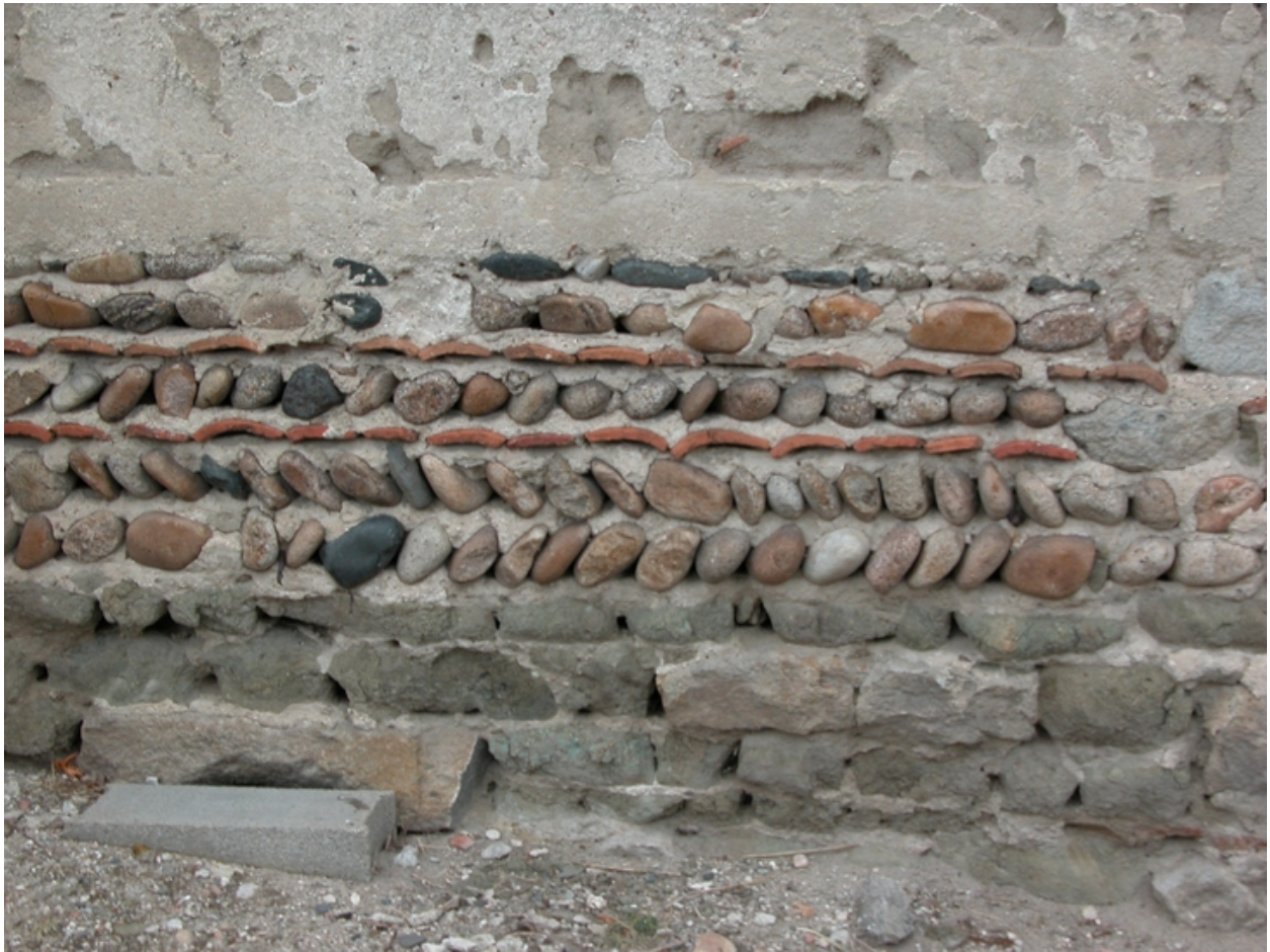
Détail de matériau : soubassement du logis en maçonnerie de galets, molasse et briques ou tuiles.
