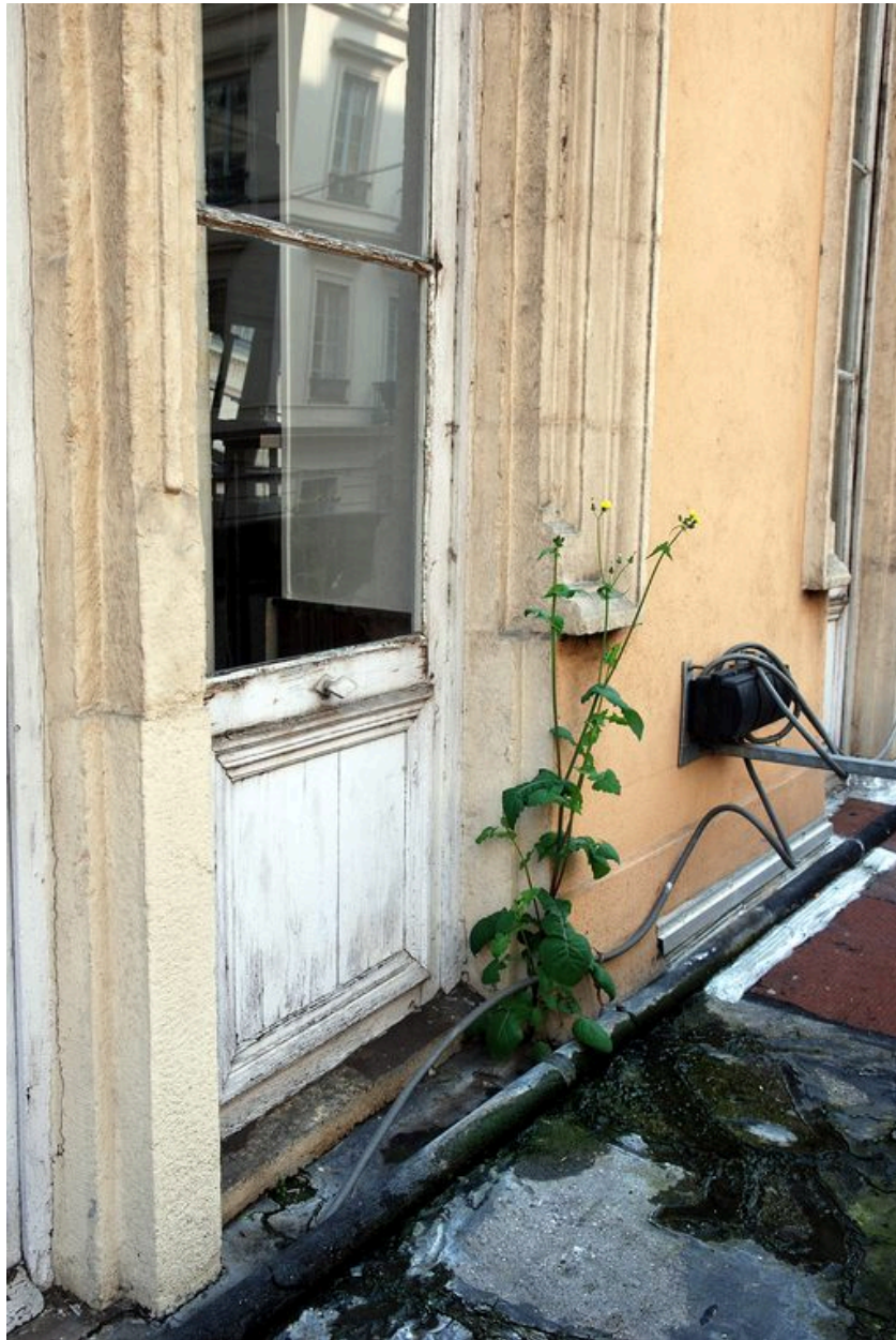
Elévation ouest : 1er étage carré, fenêtre transformée en porte-fenêtre
