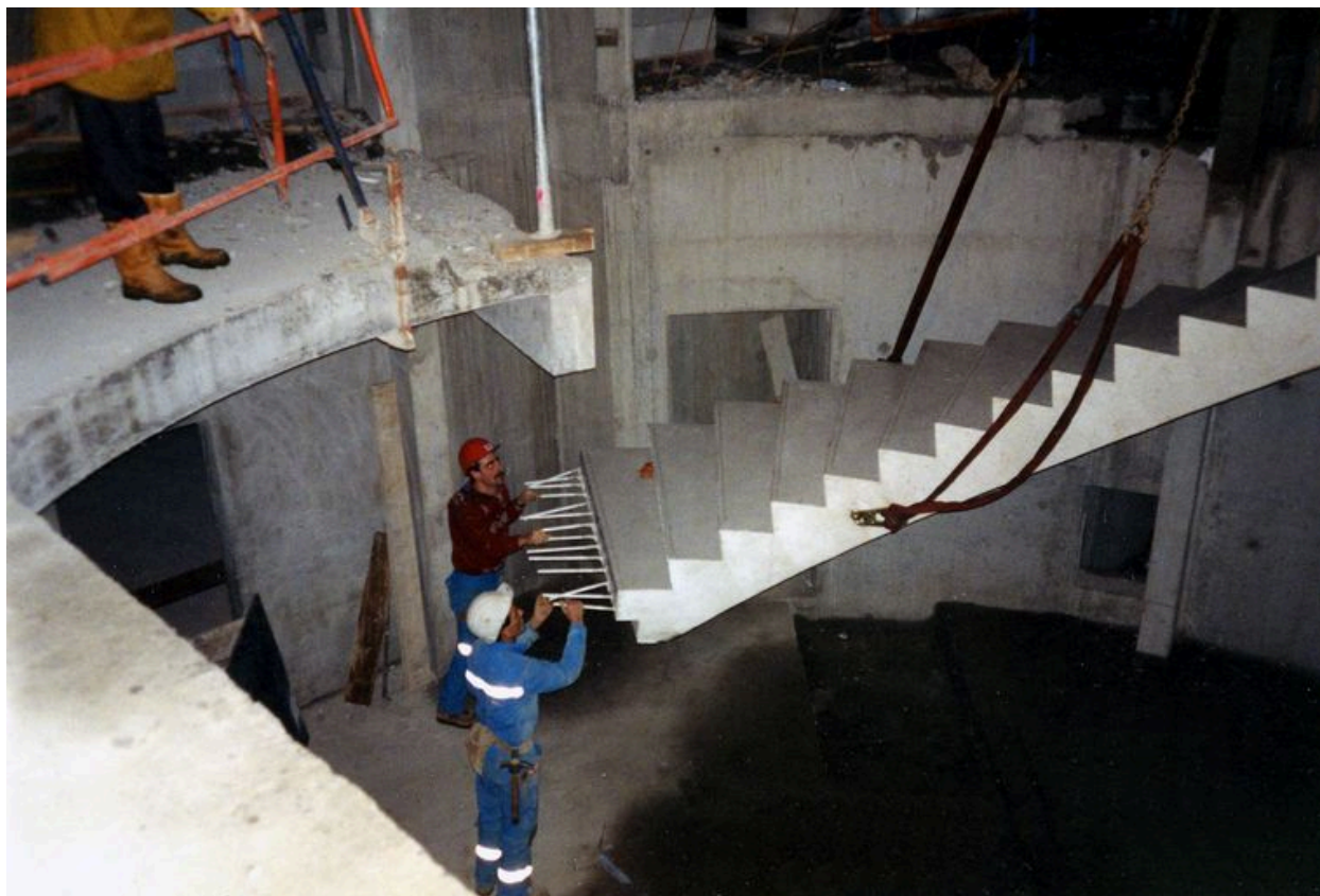
Mise en place de l'escalier, 1993
