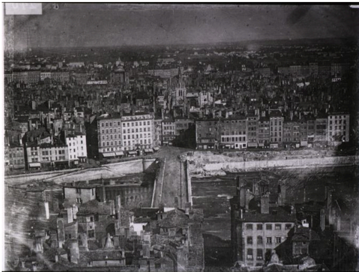
Démolition du Pont de Pierre [achèvement], fotogr., ca 1848
