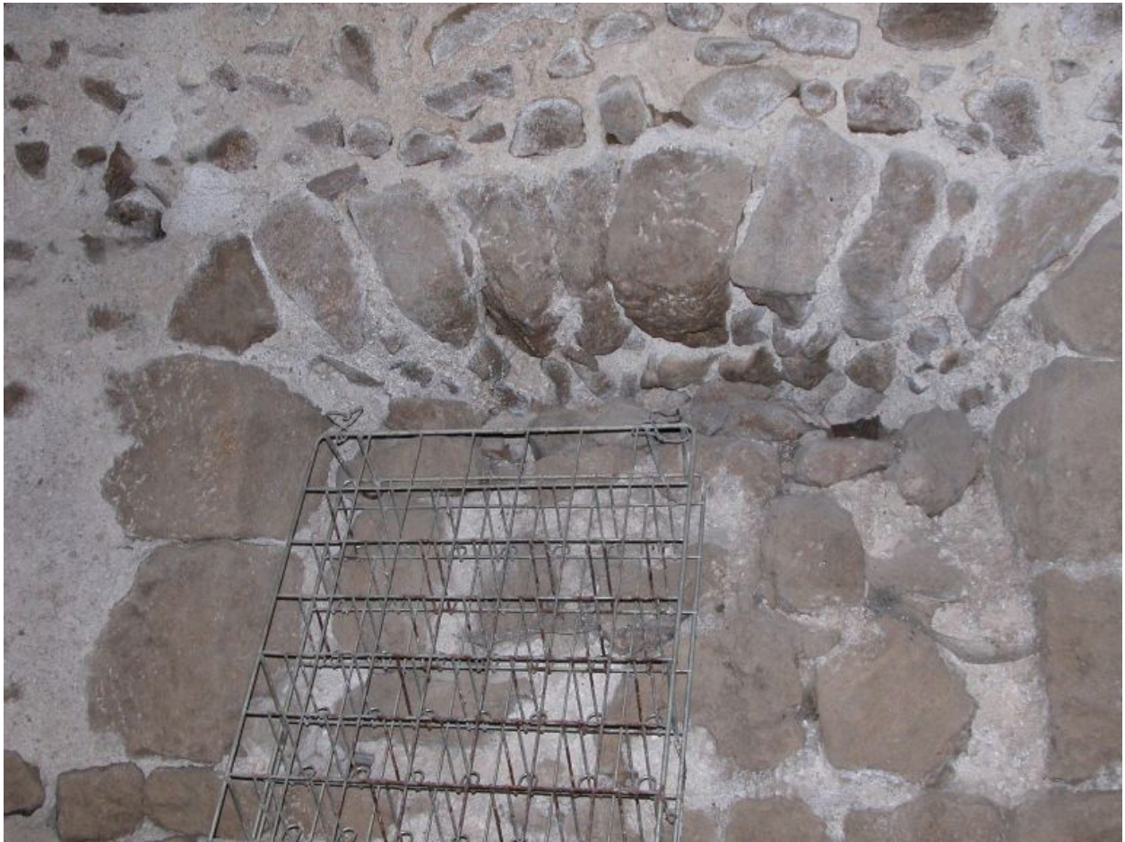
Tour de fortification du château, détail de l'intérieur du rez-de-chaussée.
