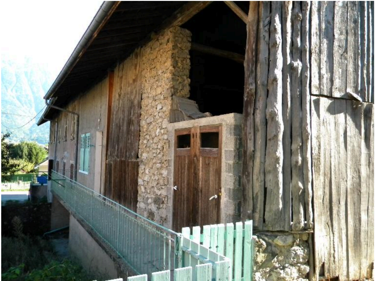
Vue de la façade sud de l'extension agricole.
