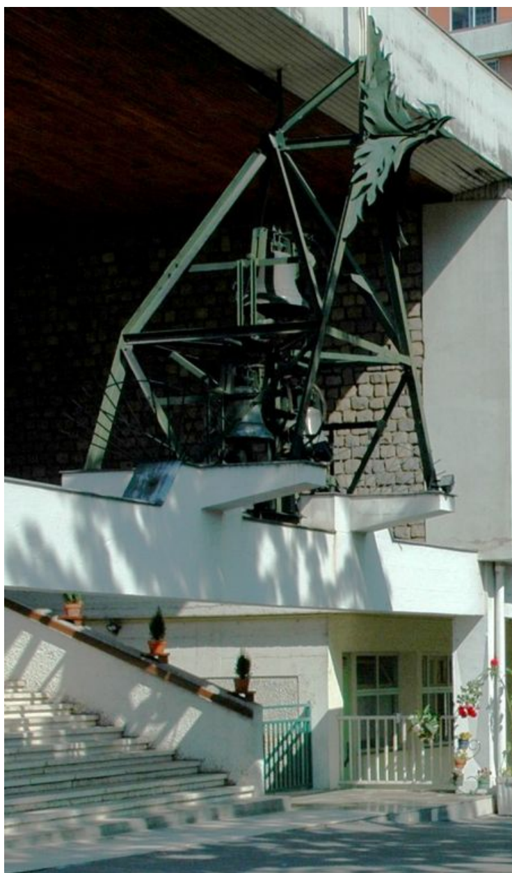
Vue générale depuis le sud-ouest
