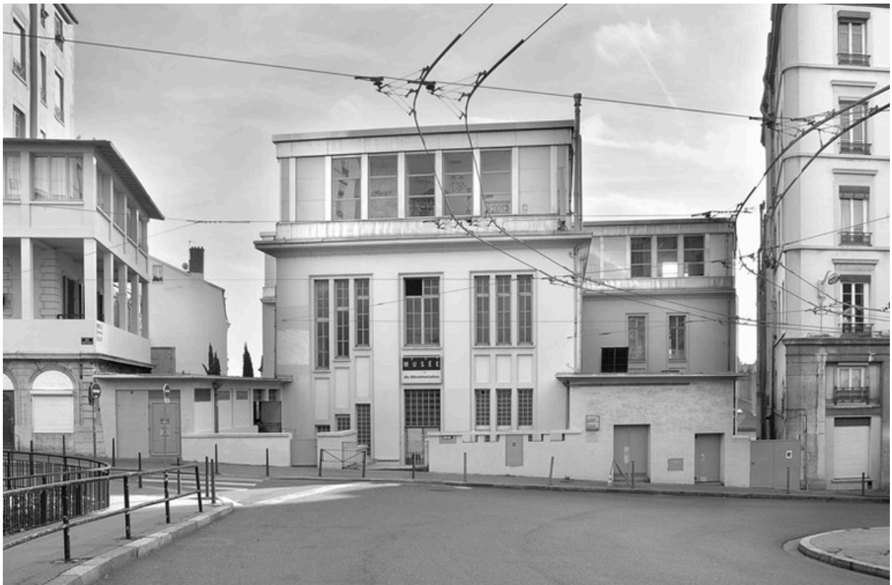
Vue d'ensemble nord (n et b)
