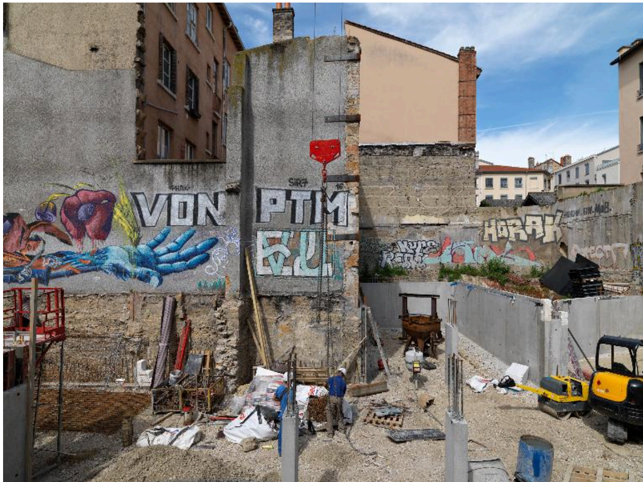
Vue du coeur d'ilôt depuis le sud, mur pignon de l'immeuble
