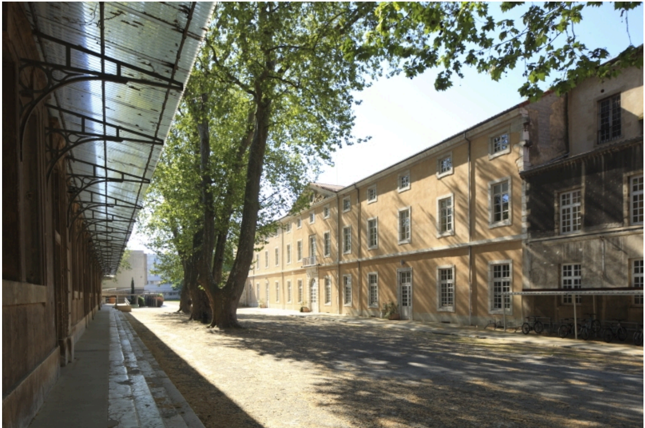
Bâtiment C. Cour intérieure sud. A gauche façade occidentale du bâtiment B, 19e.
