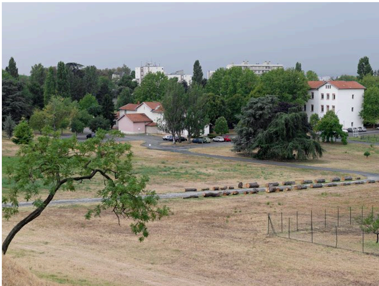
L'ancienne ferme des hommes depuis le réservoir, vue générale
