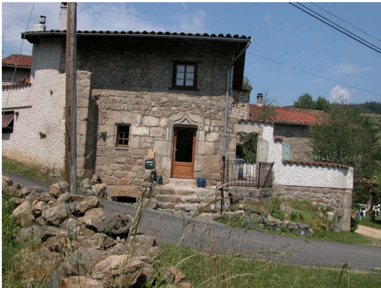
Adrets (les) (1986 AD 151, 152). Ferme 15e siècle, vue d'ensemble.
