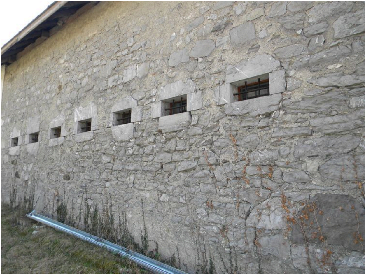
Vue de la façade arrière.
