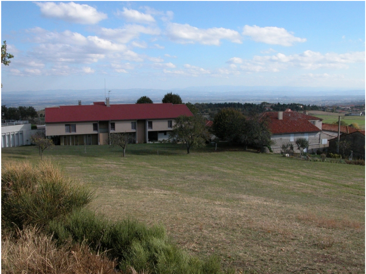
Vue du bâtiment des années 1980.
