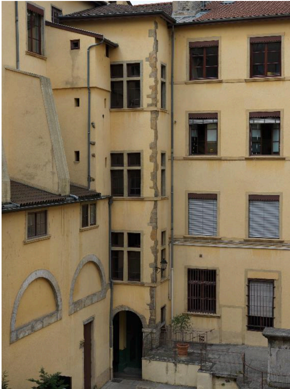
La cage de l'escalier ouest depuis l'immeuble sis 64 rue Mercière
