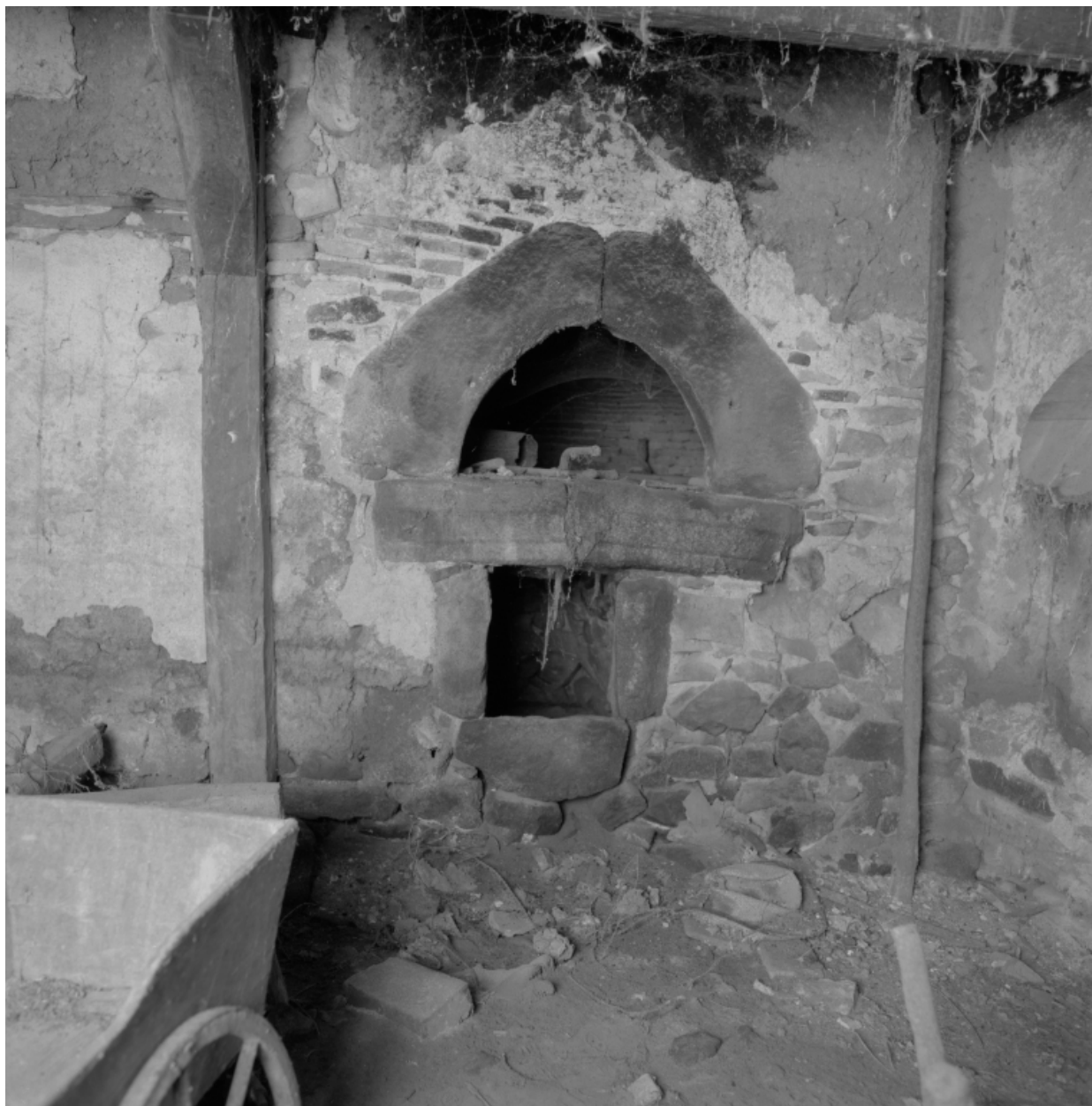
Vue du four à pain.
