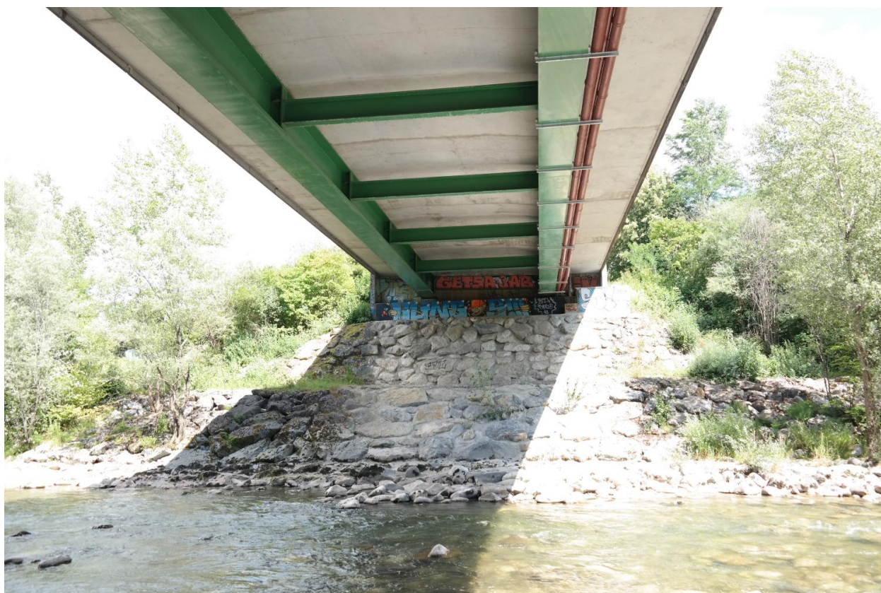
Pont sur le Fier, vue du dessous du tablier et d'une pile
